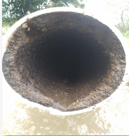
Se realizo la limpieza de aproximadamente 600 mts de tubería y se evidencia la mejora en la presión del servicio para todas las veredas.
