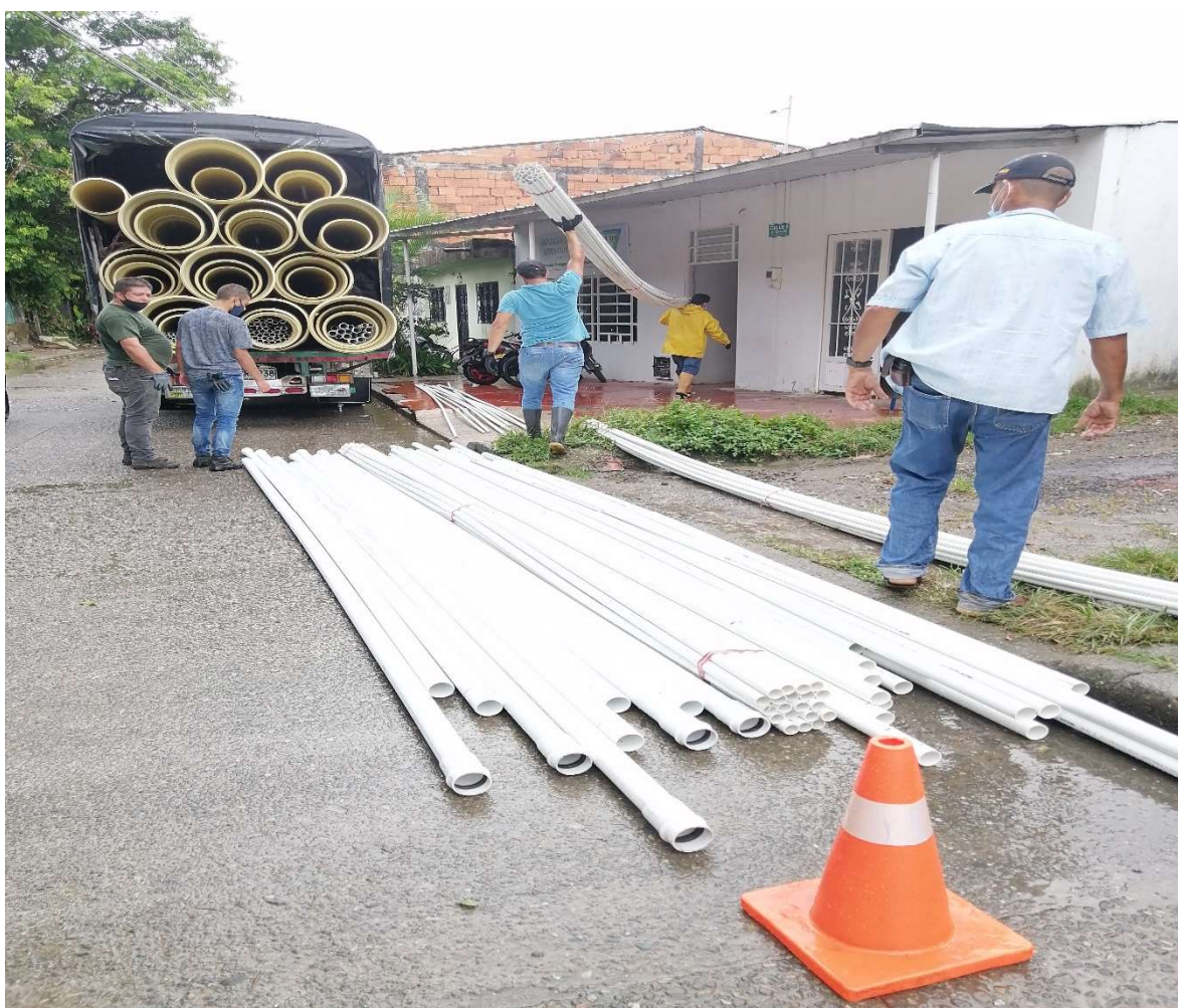
Adquisición de tubería
