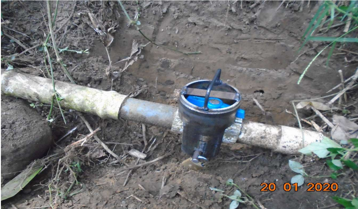
Adecuación de redes
