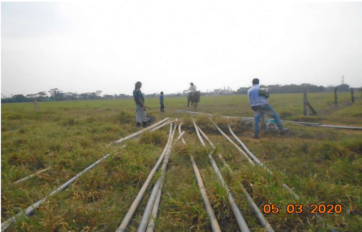
Traslado de tubería
