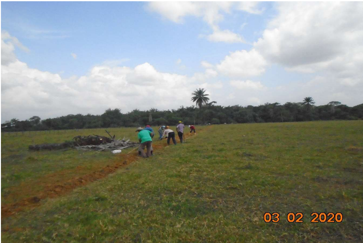
Excavación ampliación de redes
