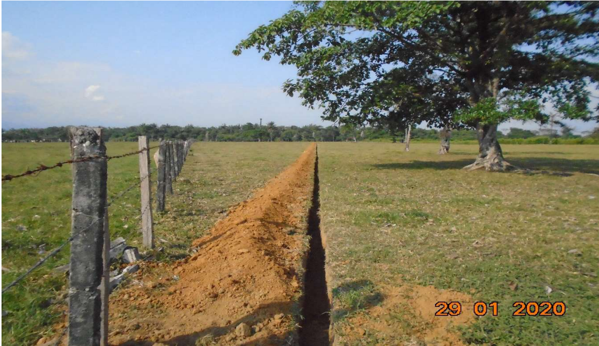
Excavación para ampliación de redes
