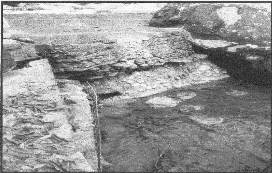
Muro de contención principal
